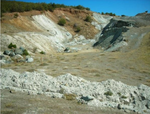
Asbest ocağı ve çevreye yayılmış asbest lifleri (Tatarcık köyü-Mihalıçcık).
